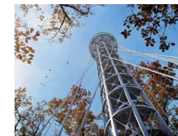
Holedná lookout tower
